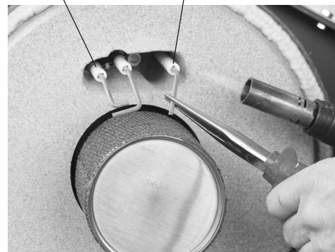
Electrod de aprindere Electrod de aprindere/ionizare
